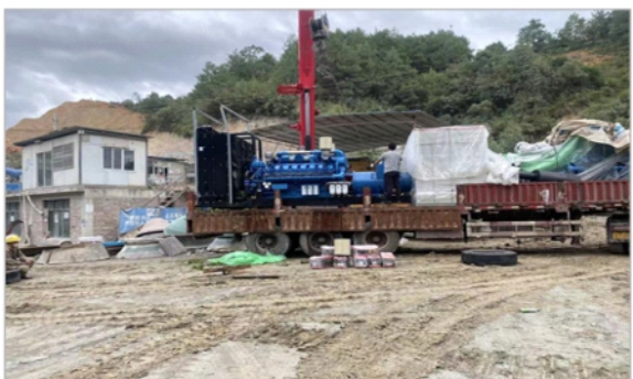
广西石业有限公司2台1350KW发电机组项目
