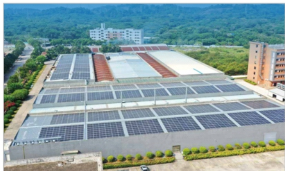
广州伟龙印刷制版有限公司1.2MW光伏发电项目
