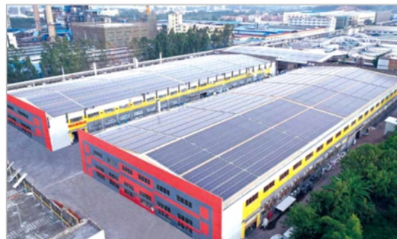
广东佛山安亿纳米材料有限公司2MW光伏发电
