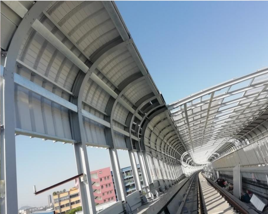
深圳市城市轨道交通6号线声屏障工程
